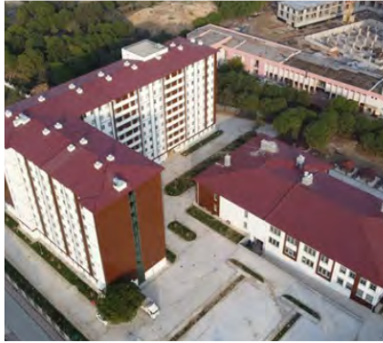
Zübeyde Hanım Dormitory
